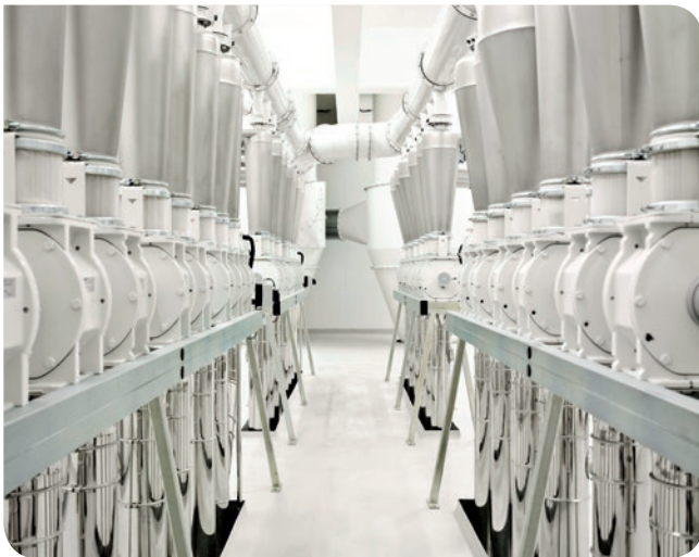
Mühlenpneumatik: Schleusentisch mit Zyklonabscheider und Austragschleuse MPSN.
